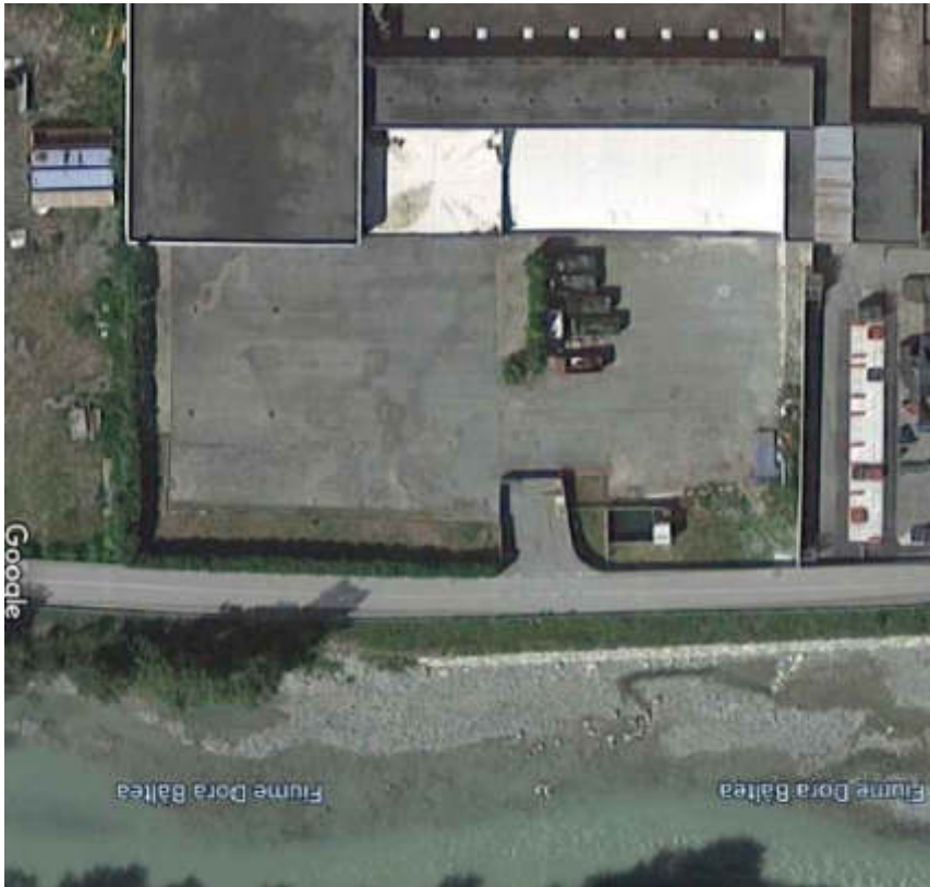
Veduta dall'alto impianto Germanplast
